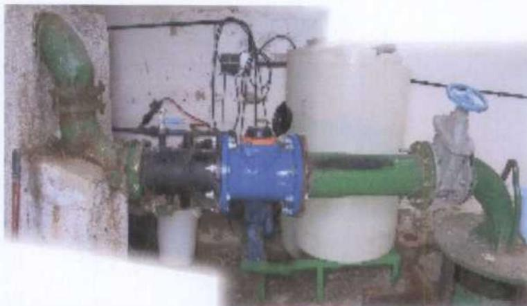
encargado de la captación. El sondeo no dispone de tubo piezométrico para el control de los niveles estático y dinámico siendo imposible efectuar estas medidas.
