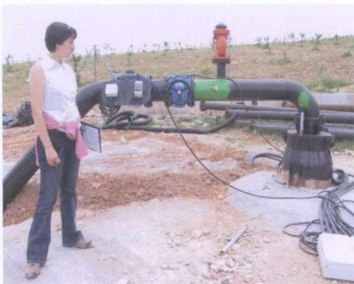
500-600 m<sup>2</sup>/día. El nivel estático se sitúa a unos 145 m de la boca del sondeo, a cota aproximada de 883 msnm., y sus aguas serán conducidas al futuro depósito de 5.000 m<sup>3</sup>, situado en las inmediaciones a cota de 1.020 msnm.
