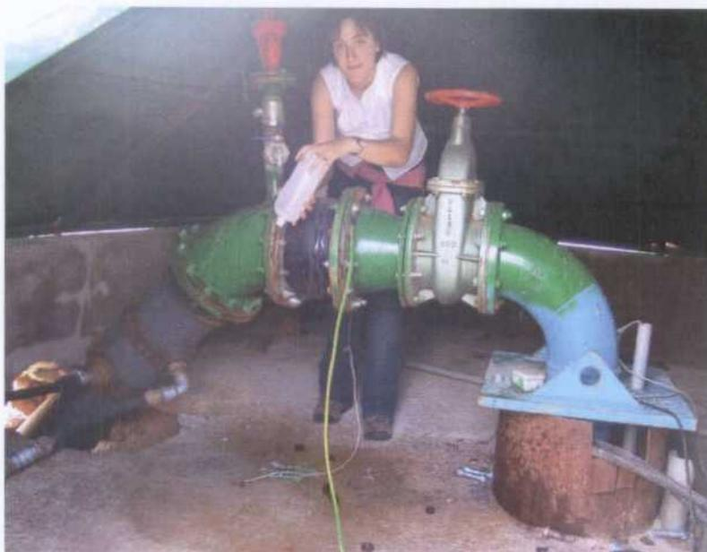
y vierte directamente al depósito D-1, situado a cota de 885 msnm. Utiliza una electrobomba sumergible de 125 C.V. marca WORDTINTONG, situada la aspiración a 180 m de profundidad. La tubería de impulsión es de 8" en acero. La impulsión puede funcionar manual y automáticamente mediante sondas de arranque electrónico y limitación horaria en
